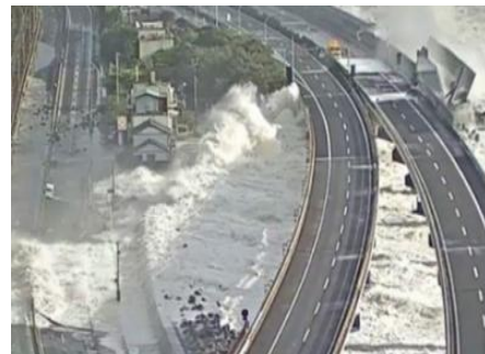
高潮被害による通行止め状況
