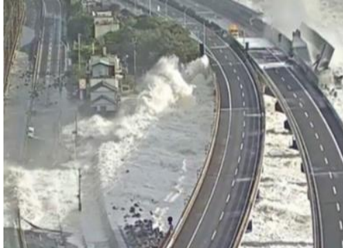
高潮被害による通行止め状況
