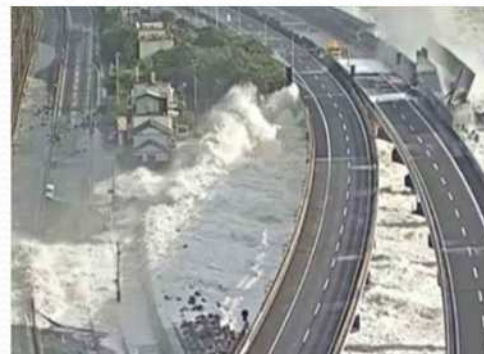
高潮被害による通行止め状況
