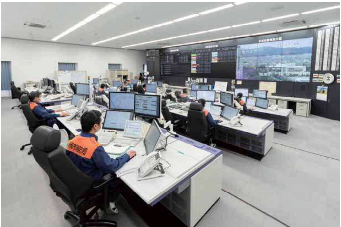
消防総合情報システム
