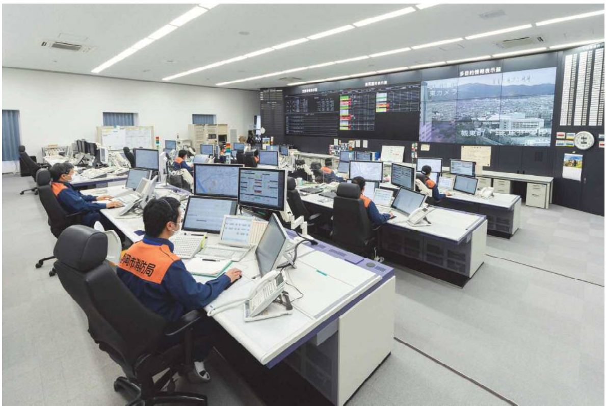
消防総合情報システム
