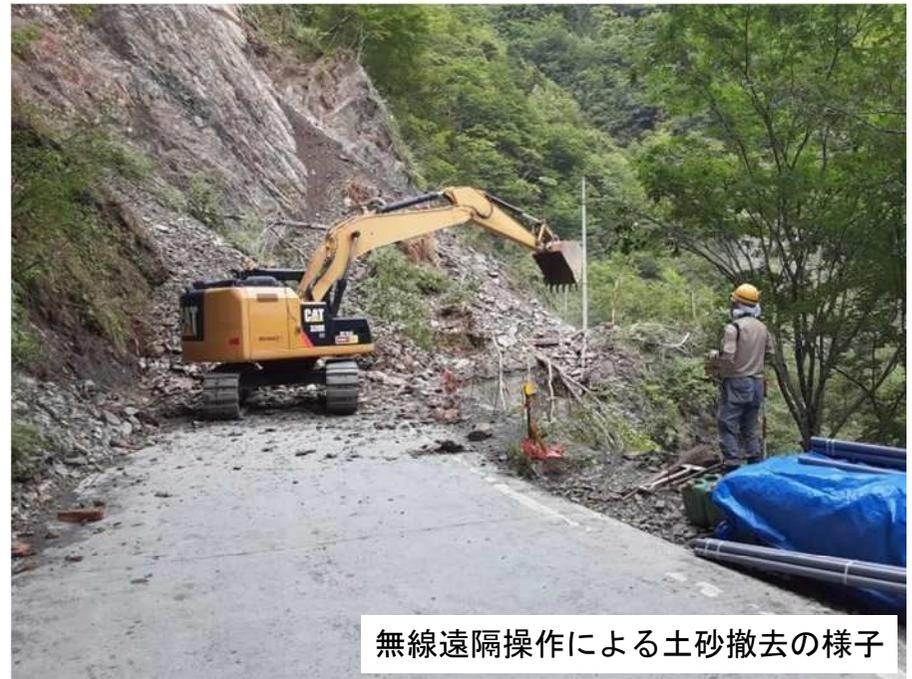
無線遠隔操作による土砂撤去の様子
