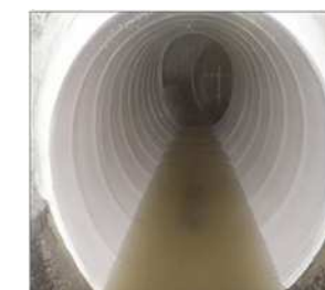
下水道管の耐震化施工
