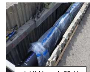
水道管の布設替
