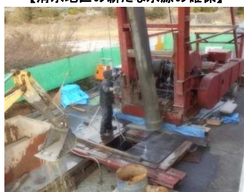
井戸の新設工事イメージ
