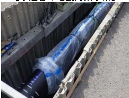
耐震化された水道管への布設替
