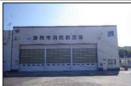
【消防ヘリ格納庫】
