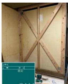
【筋かいによる補強】
