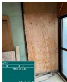
【構造用合板による補強】
