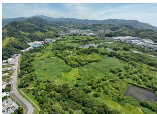
令和6年撮影 現在は残土あり
