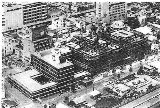
写真1 施工状況（昭57年5月末）
