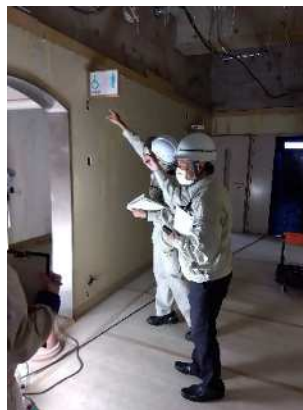
設備工事（衛生）
