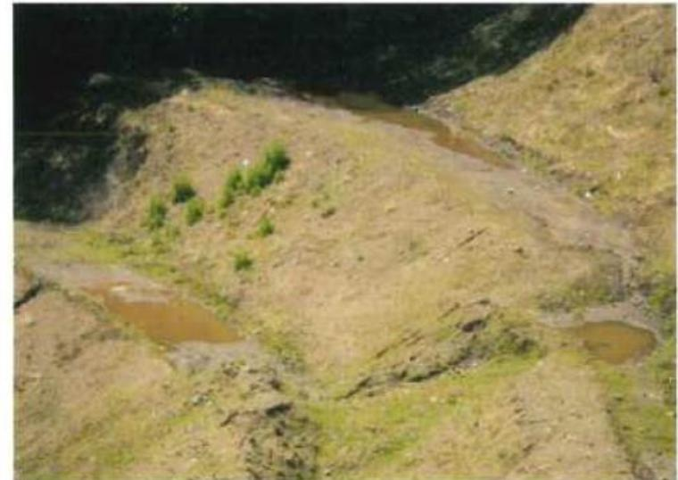
小段勾配の処理の悪さによる盛り土法面の水溜り
