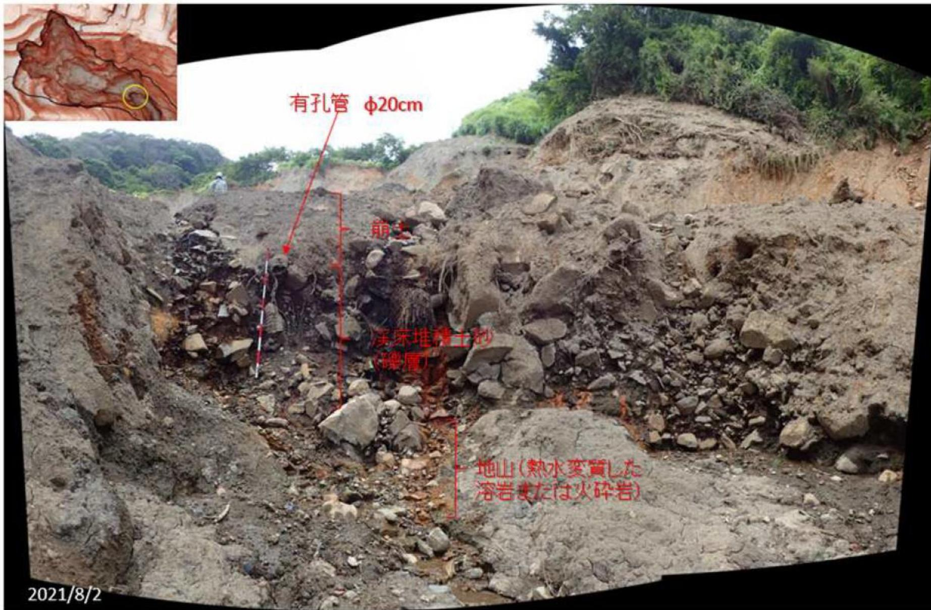
写真⑱ 崩落地下端付近に見られる有孔管
