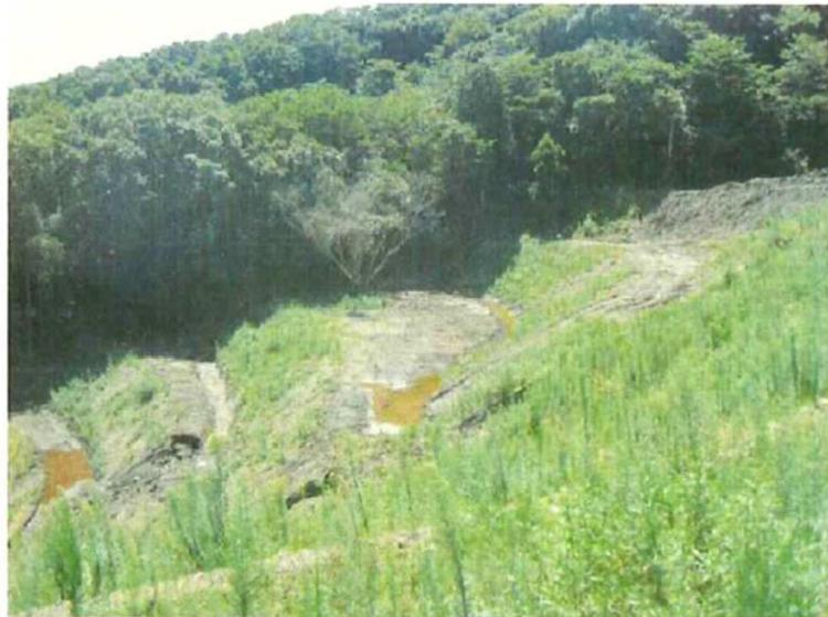
排水状況が悪く、小段の上に水たまり、左岸側に水みち、崩壊が見られる
