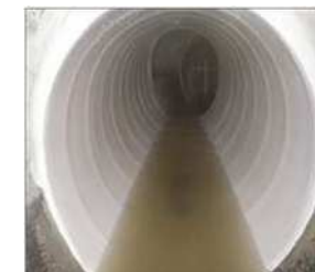
下水道管の耐震化施工
