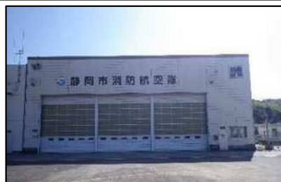
【消防ヘリ格納庫】
