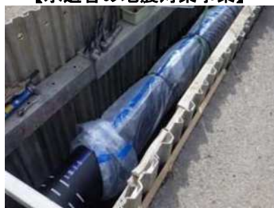
耐震化された水道管への布設替
