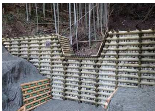
〔木製の谷止工〕
