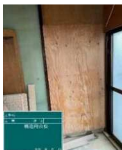
【構造用合板による補強】
