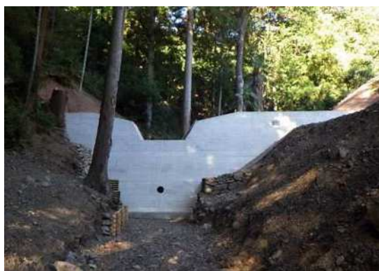
〔コンクリートの谷止工〕
