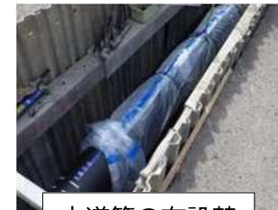
水道管の布設替
