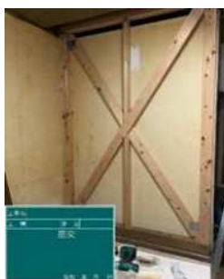
【筋かいによる補強】
