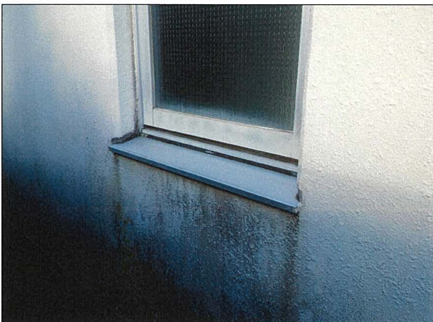
旧清水西河内小学校 アスベスト事前調査業務
