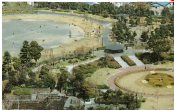
建設当時の城北公園の状況
