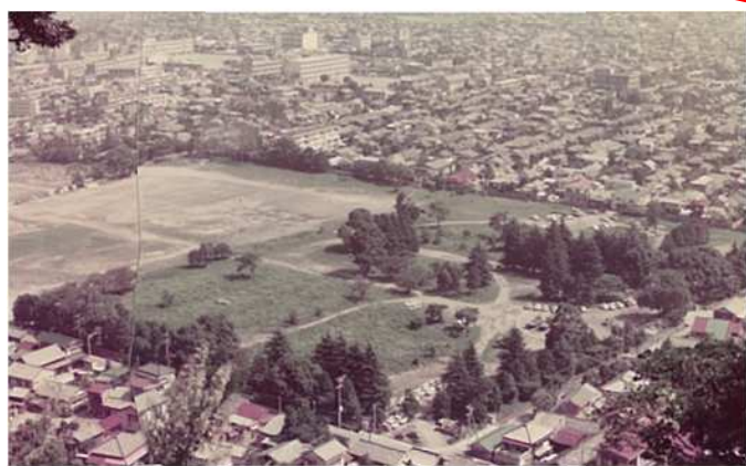
静岡大学解体後の状況
