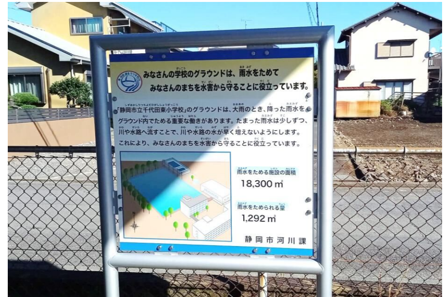
グラウンド貯留 (千代田東小学校)
