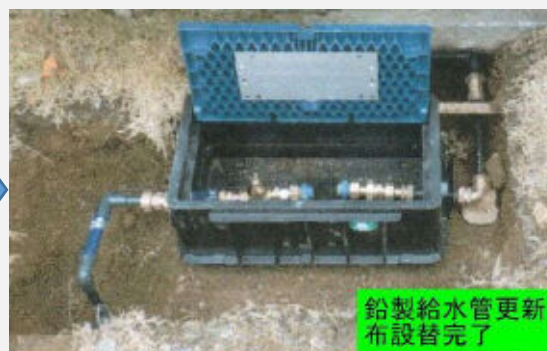
(写真1: 鉛製給水管更新修繕)
