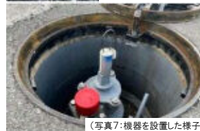
(写真7: 機器を設置した様子)
