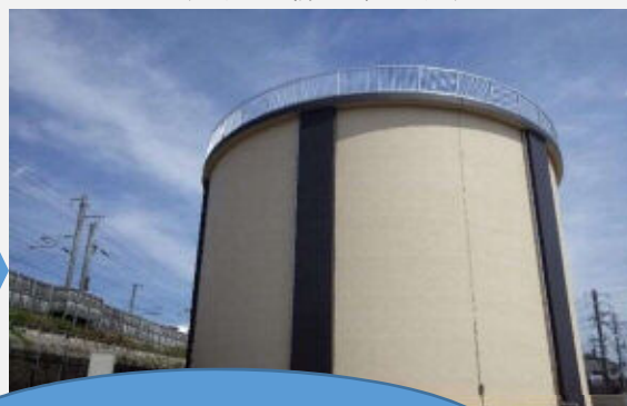
(写真3: 新しい配水池)
