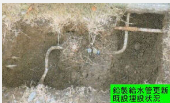
(写真1: 鉛製給水管更新修繕)
