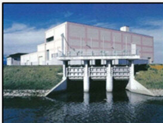
(写真2: 雨水ポンプ場*)
