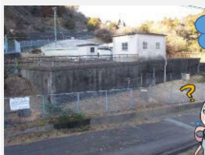
(写真1: 老朽化した配水池)
