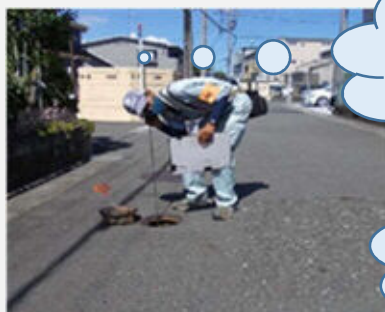
(写真1: 機器による調査の様子)
