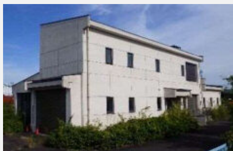
(写真1:宮加三ポンプ(廃止予定))
