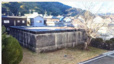
(写真1: 既設配水池)
