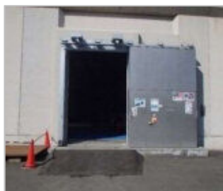
(写真4:防水扉の設置)
