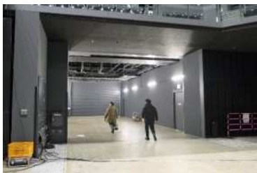
大型トラックが通れる搬入口 （SAGAアリーナ）
