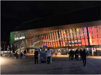
2階デッキ・エントランス（SAGAアリーナ）
