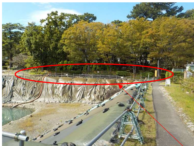
現況①(建設敷地箇所)
