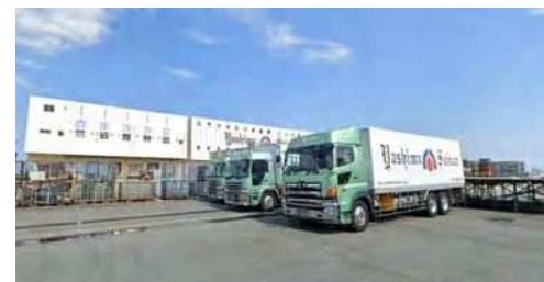
冷蔵庫団地の外観
