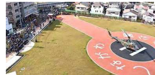
防災機能を備えた公園（品川区）
