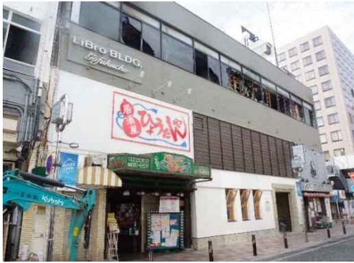
建物南東側から撮影
