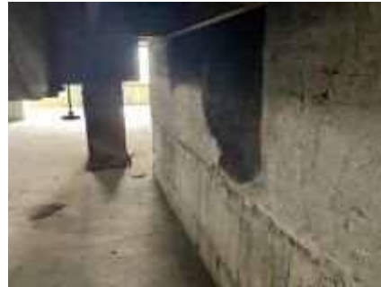
写真 48 ダクトを囲む壁面の焼損状況 写真 49 火点室東側壁面焼損状況
