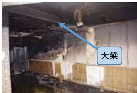
写真 42 空室内の大梁
