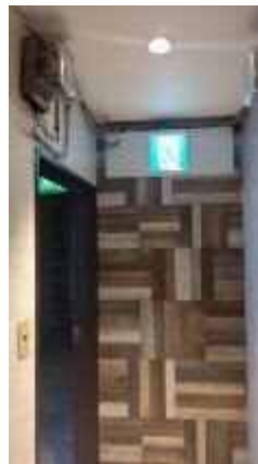
写真 19 ダクトを囲む壁面（図 18②）
