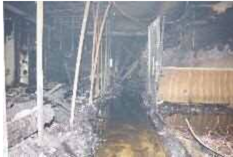
写真 33 中央通路の状況 (図 19⑩)
