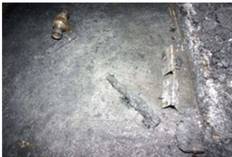
写真 29 休憩室出入口ドア周辺の状況
