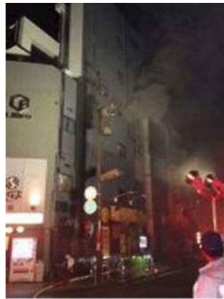
写真 17 火元建物北側
