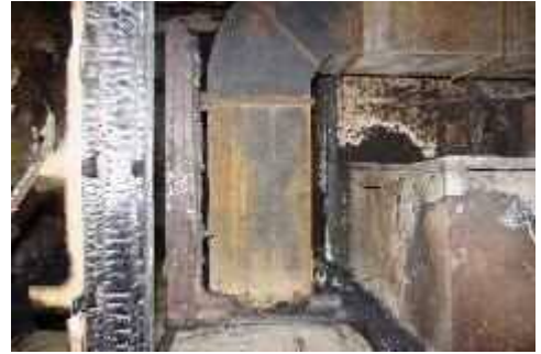
写真 28 ダクト周辺の状況 (図 19⑦)
