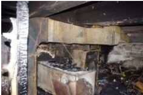
写真44 火点室のダクトの状況
