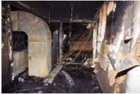
写真 27 ダクト周辺の状況 (図 19⑥)
