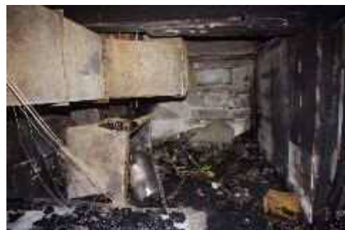
写真35 火点室の状況
