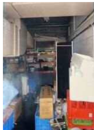
写真 21 火災前の休憩室（図 18③）
