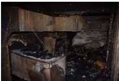
写真34 火点室の状況
