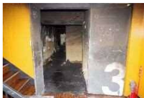
写真 22 3階フロア入口(図 19①)
