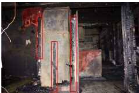
写真 63 ダクトを囲む壁面の空気流入箇所 写真 64 ダクトを囲む壁面の空気流入箇所
