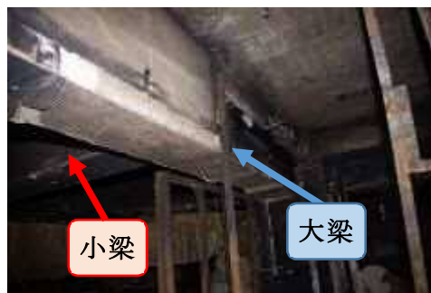
写真 43 大梁及び小梁の状況
