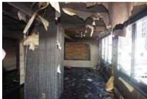
写真 24 空室①の状況（図 19③）
