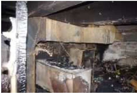
写真 36 ダクトの焼損状況
