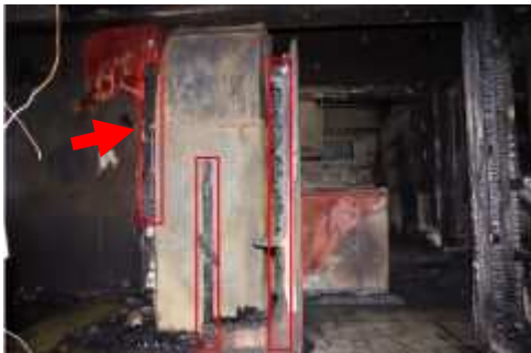
写真 63 ダクトを囲む壁面の空気流入箇所
