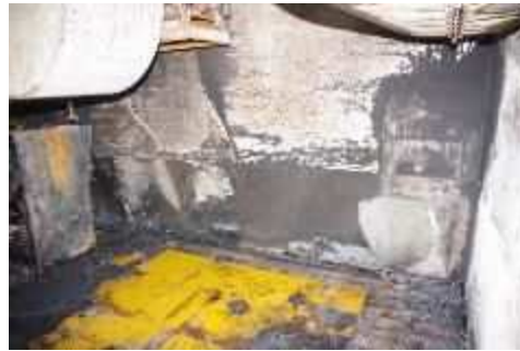
写真 37 南面の焼損状況
