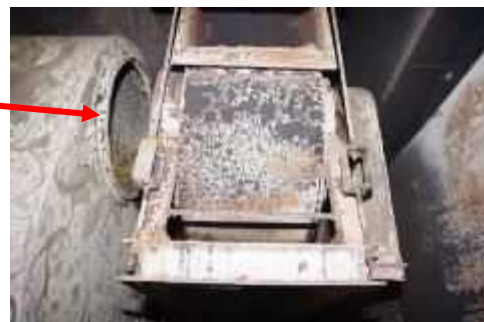
写真 62 ダクト繋ぎ目部分の空気流入箇所
