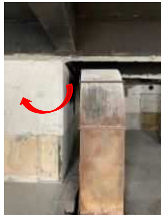
写真 64 ダクトを囲む壁面の空気流入箇所
