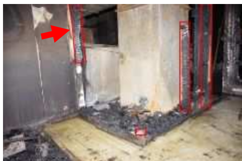
写真46 ダクトを囲む壁面の焼損状況
