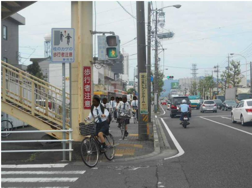
図 歩道幅員を阻害する横断歩道橋の利用状況（駿河区：有東歩道橋 南側）
