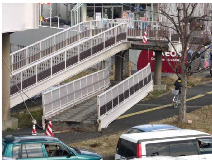
図 被災時に落橋した横断歩道橋の状況 (仙台市若林区)
