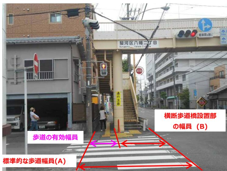
図 歩道の有効幅員の算定イメージ
