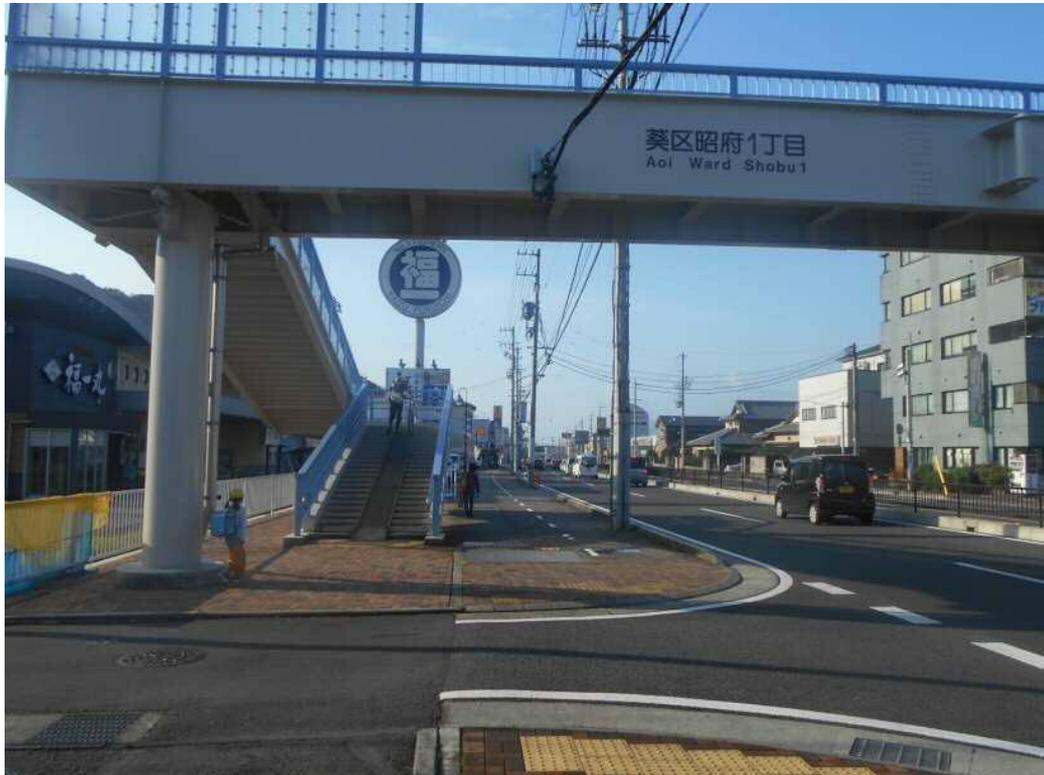
図 歩道幅員を阻害しない近年整備の横断歩道橋（葵区：昭府一丁目歩道橋 東側）
