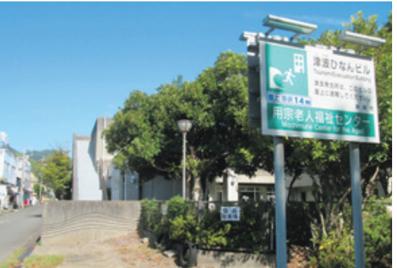
津波避難ビル
