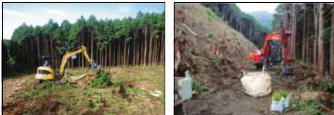
図 49 グラブブルによる地留え（左図）とスイングヤーダによる苗木運搬
