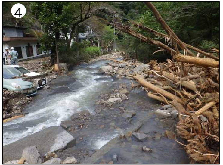
写真右側の流木が溜まっているところは川です。木と土でふさがれた川の水があふれ、真ん中の道路が川のようになっています。左側の建物に土と水が流れ込みました。
