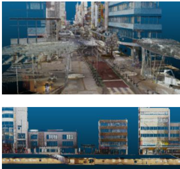
紺屋町の地上と地下の構造を把握するために点群データ（座標情報を持つ点の集合データ）を取得
