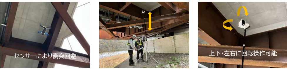
UAV 点検ロボットカメラ
