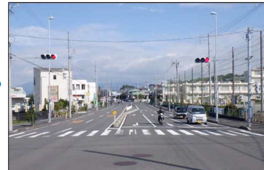
整備後(改良済区間)
