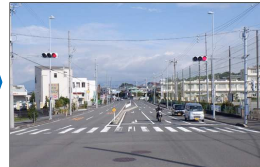
整備後(改良済区間) 43
