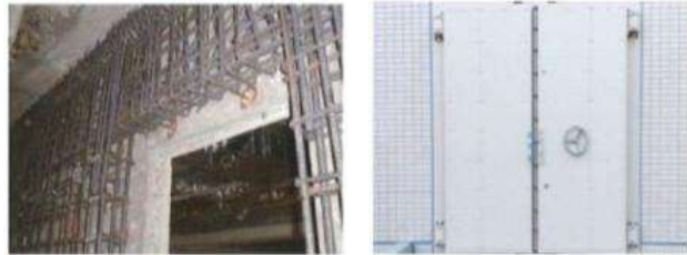
耐津波壁化(構造の強化) 防水扉の設置(防水化)
