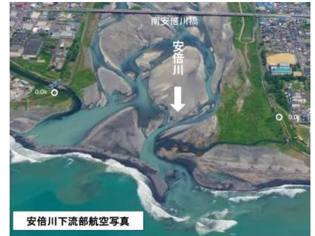
安倍川下流部の河床の状況
