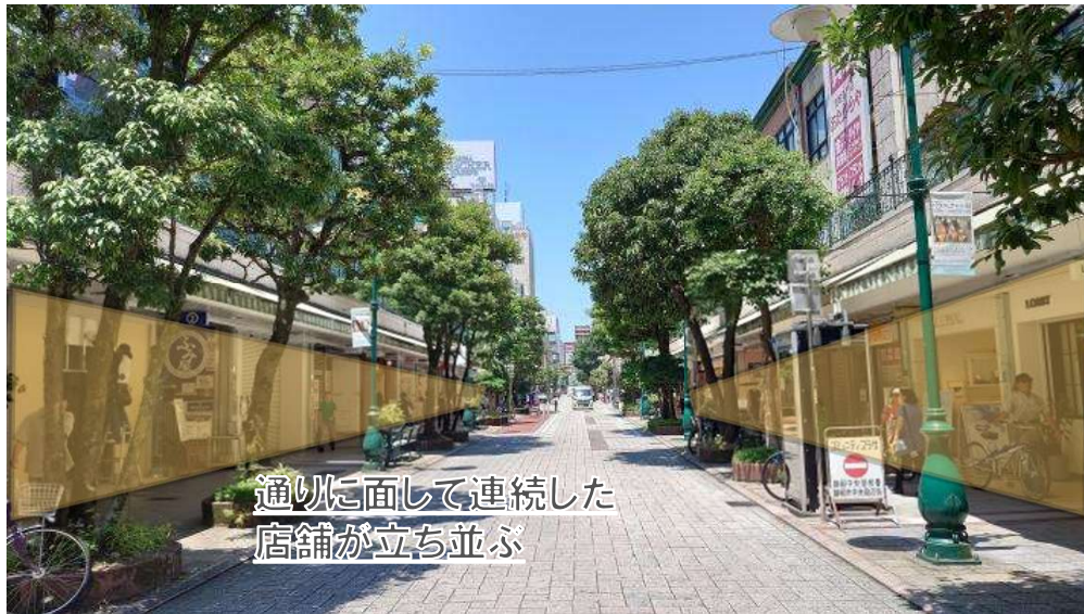
写真：呉服町通り（連続した店舗の様子）
