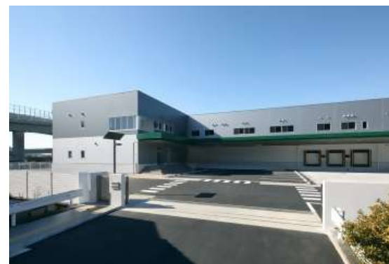
門屋学校給食センター
