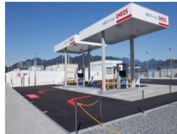
▼ 静岡清水水素ステーション外観
