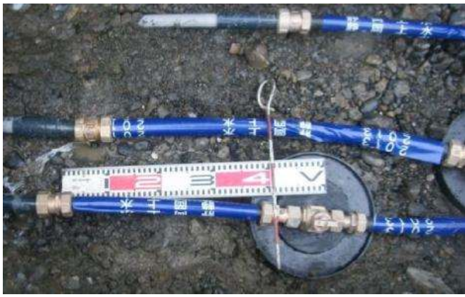
鉛製給水管布設替え後
