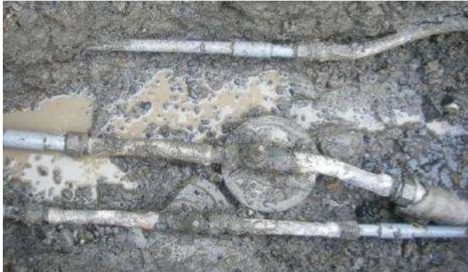
鉛製給水管布設状況
