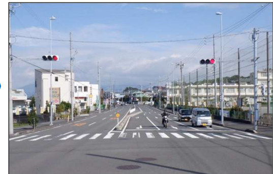
整備後(改良済区間)
