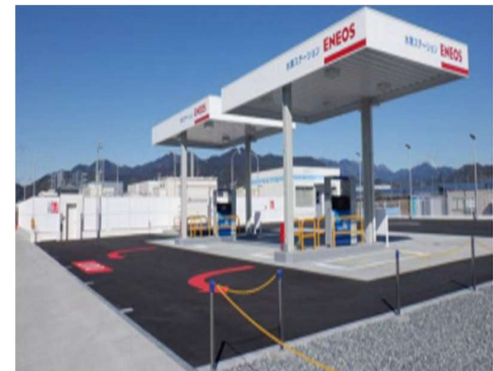
▼ 静岡清水水素ステーション外観
