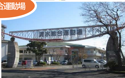
設備：アリーナ、陸上競技場、 武道場、アーチェリー場、 弓道場、屋外プール
