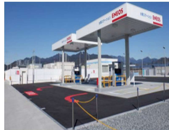
▼ 静岡清水水素ステーション外観
