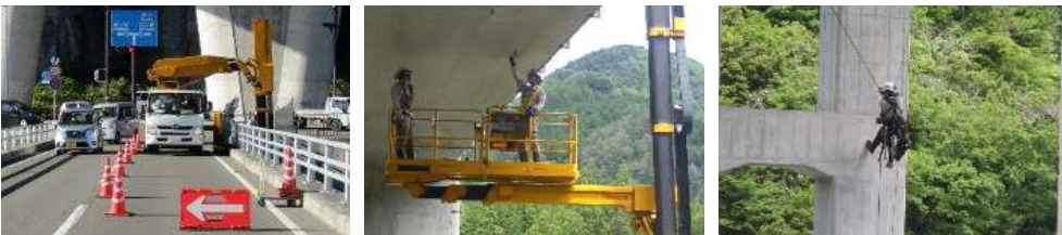
交通規制 橋梁点検車 ロープアクセス
