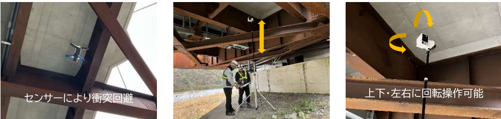
UAV 点検ロボットカメラ
