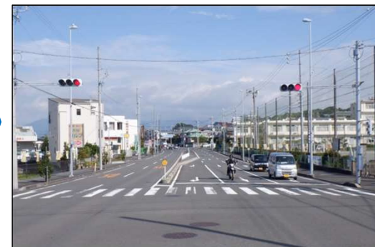
整備後(改良済区間)
