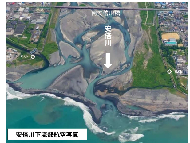
安倍川下流部の河床の状況
