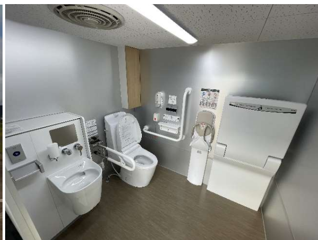
多目的トイレ室内
