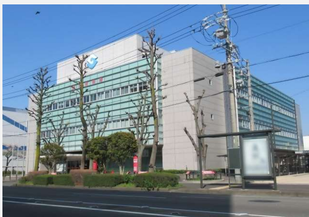
駿河区役所（駿河区南八幡町）
