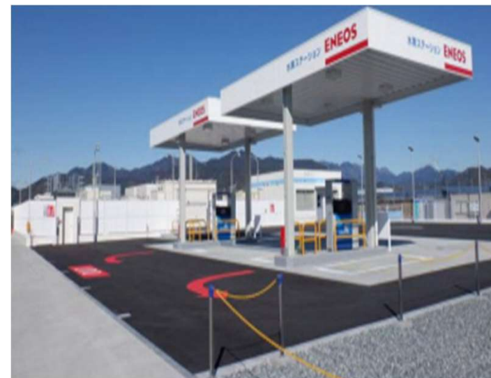
▼ 静岡清水水素ステーション外観
