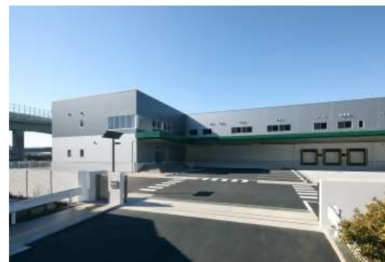
門屋学校給食センター
