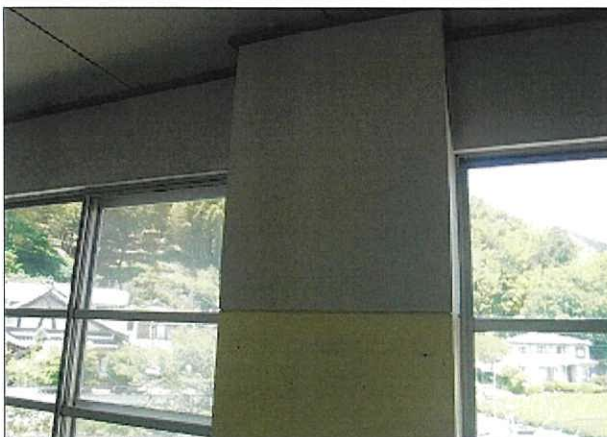
箇所: 廊下(1階~3階) 壁
