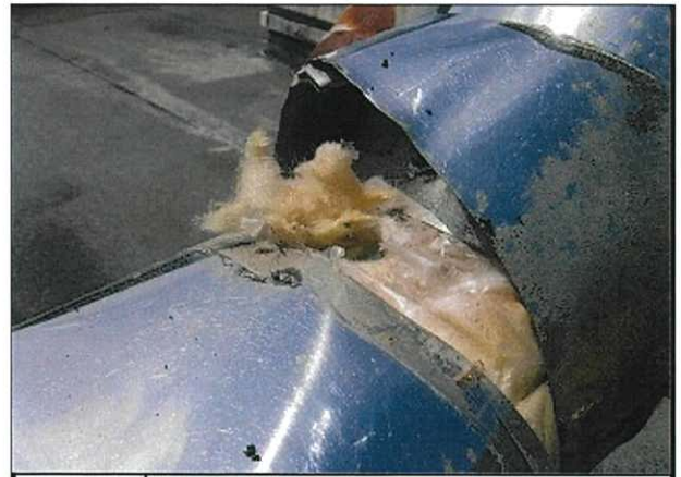
箇所: 屋上 配管被膜部 グラスウール
