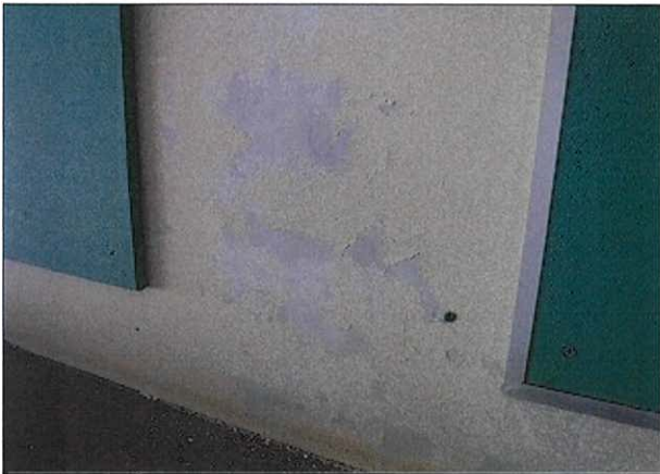
箇所: 昇降口 内壁
