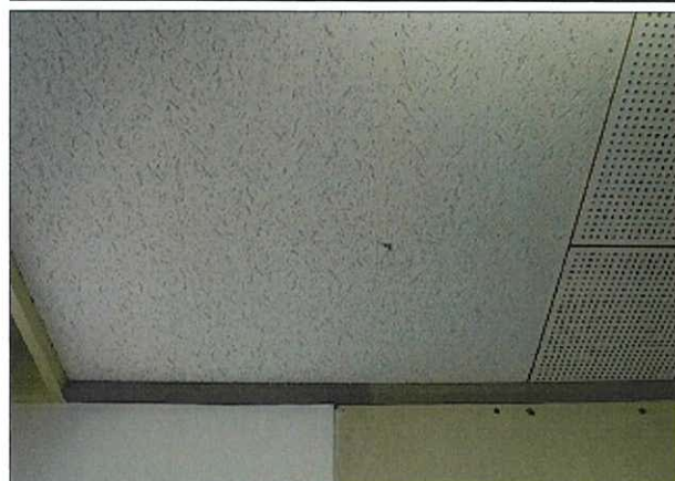
箇所：放送室 天井 岩綿吸音板
