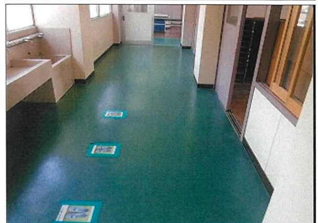
箇所: 廊下(1階~3階) 床
