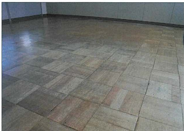
箇所：多目的室 床
