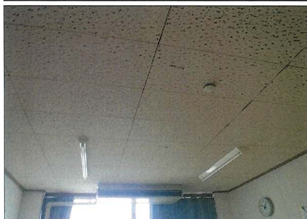
箇所: コンピューター室 天井
