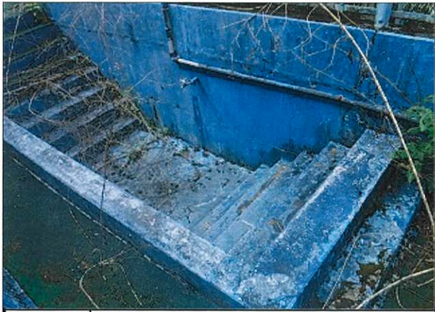
箇所: プール 洗体槽
