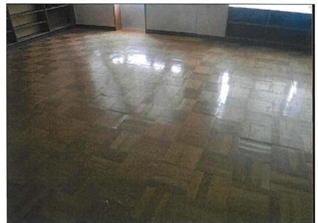
箇所: 多目的室 床
