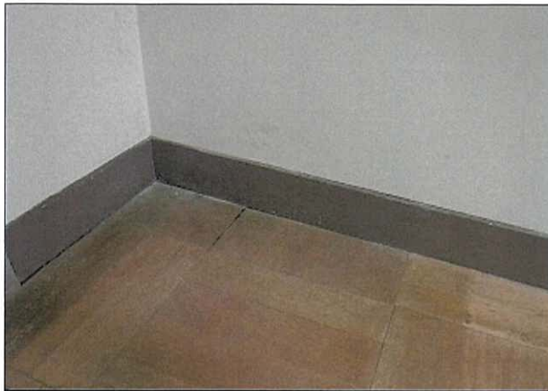
箇所：理科準備室 壁・巾木
