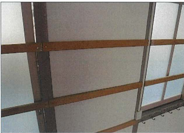
箇所: 多目的室 内壁
