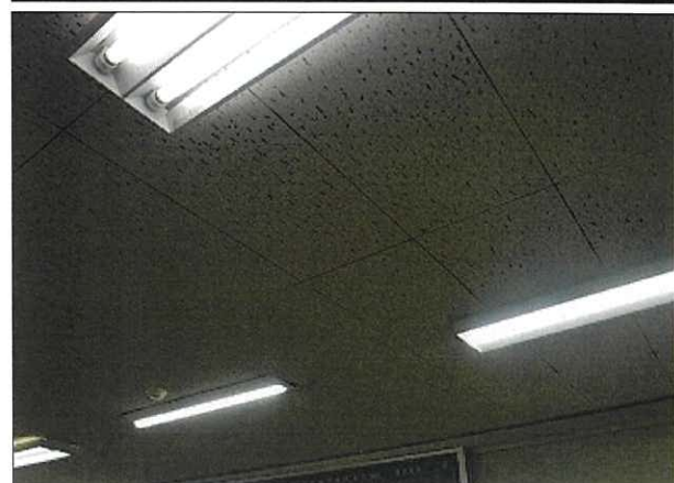
箇所: 職員室 天井
