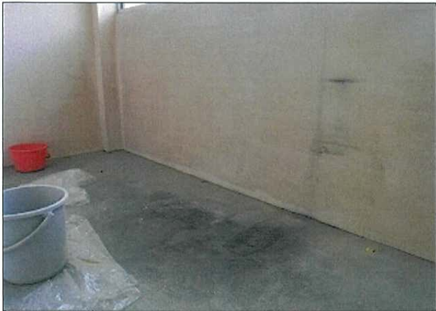
箇所: 3階 準備室 床・壁
