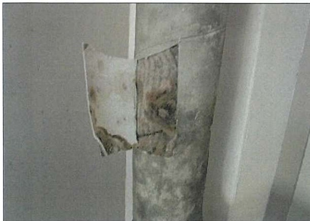
箇所：郷土資料室 室内配管 被膜部
