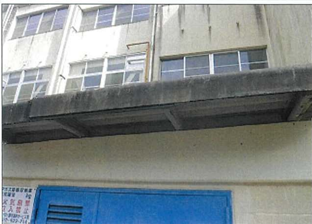
箇所: プロパン置場
