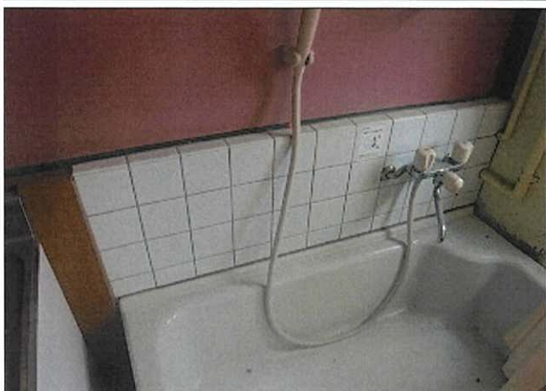
箇所: 保健室(洗体槽) タイル部
