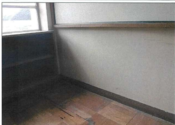
箇所: 普通教室(1年) 内壁
