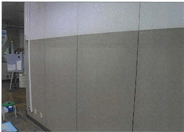
箇所：職員室 内壁
