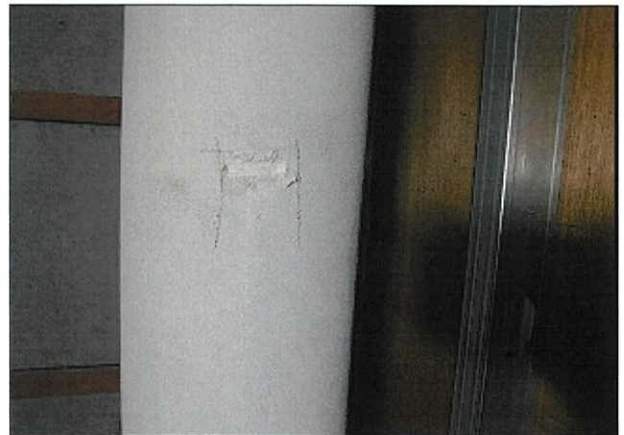
箇所: 郷土資料室 パイプスペース 配管被膜 トミジ管
