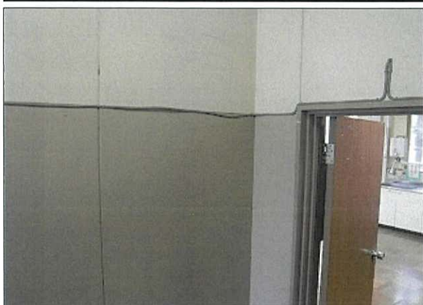
箇所：放送室 内壁
