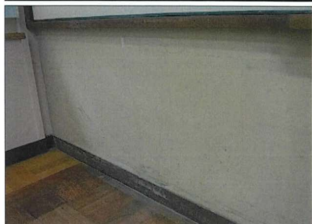
箇所: 普通教室(5・6年) 内壁
