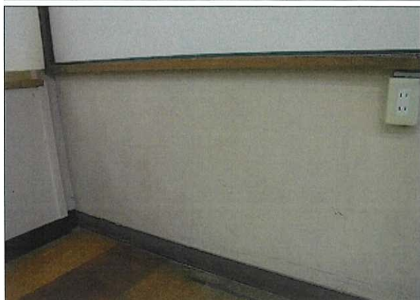
箇所: 普通教室(2年) 内壁
