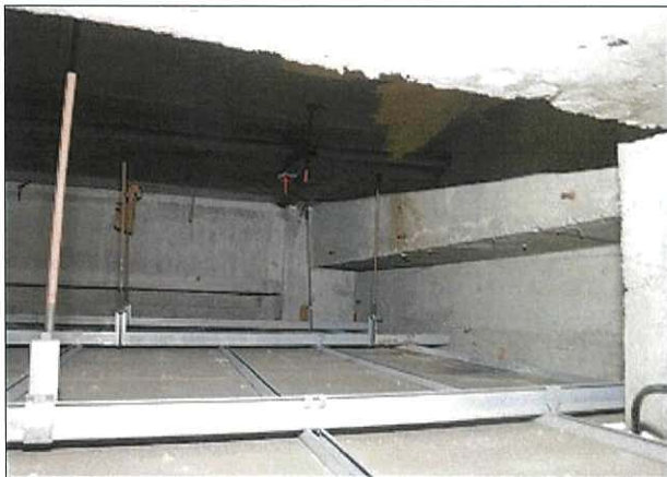
箇所: 3階 天井裏 スラブ 吹付け等無し
