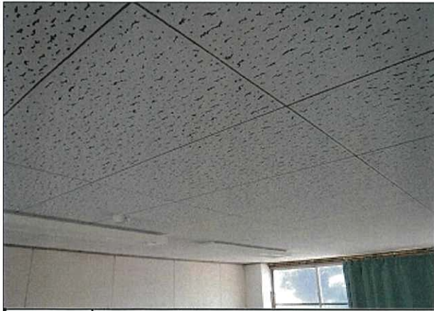
箇所：理科・家庭科室 天井
