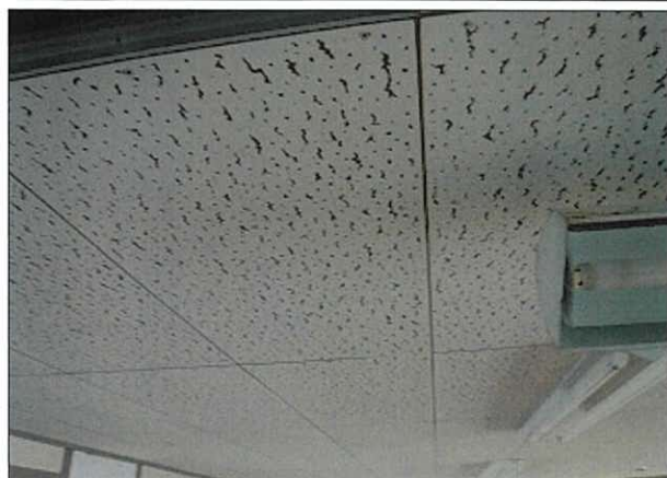
箇所：図工室 天井
