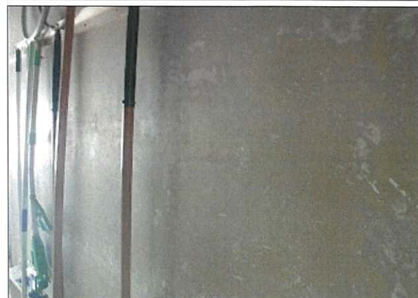
箇所: 1階 倉庫 内壁
