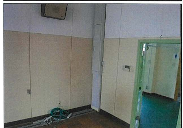
箇所: コンピューター室 内壁
