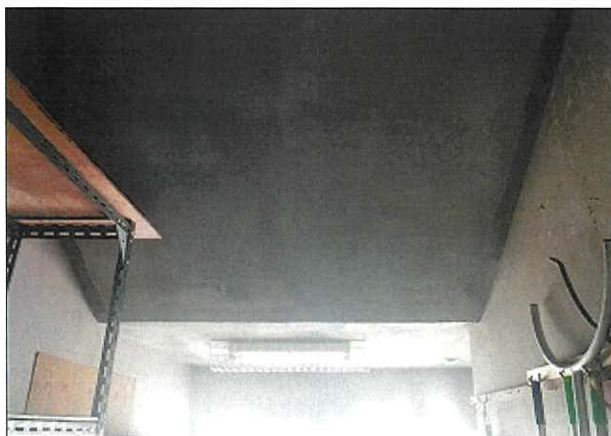
箇所: 1階 倉庫 天井
