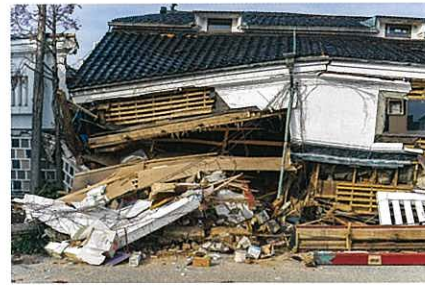
地震による被害例 (能登半島地震)
