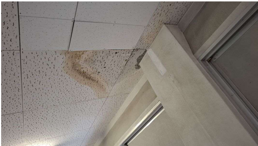
1 ②北校舎 3F 廊下の雨漏り
