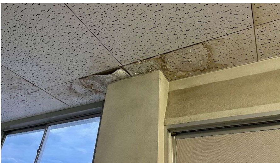
1 ③北校舎 3F 廊下の雨漏り
