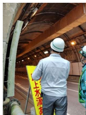
(国)150号新日本坂トンネルラジオ再放送設備更新工事
