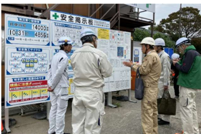
清水谷津浄水場場内配管及び着水井更新工事
