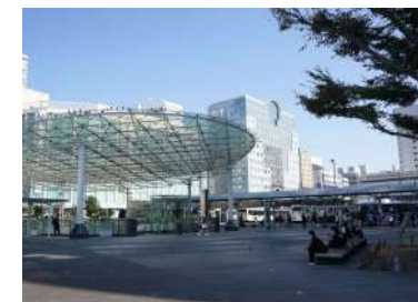
静岡駅北口駅前広場
